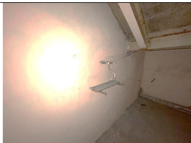
Фото 21. Типичное состояние Объекта оценки (помещение 2-Н)
