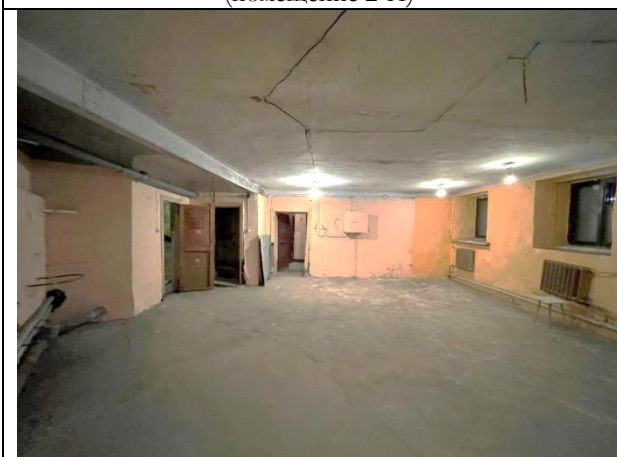
Фото 19. Типичное состояние Объекта оценки (помещение 1-Н)
