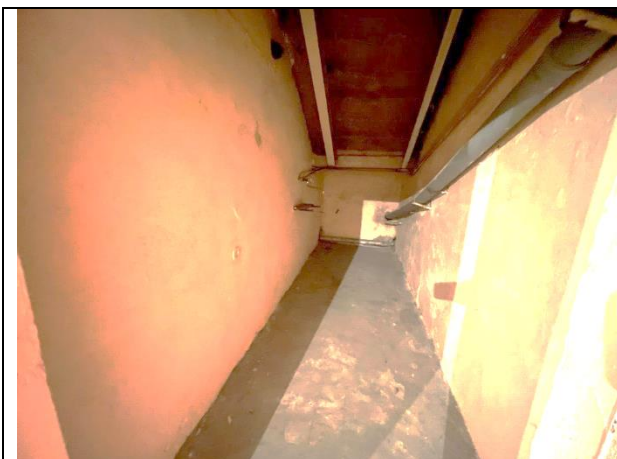
Фото 20. Типичное состояние Объекта оценки (помещение 2-Н)
