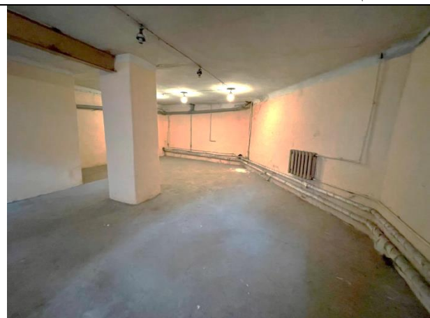
Фото 19. Типичное состояние Объекта оценки (помещение 2-Н)
