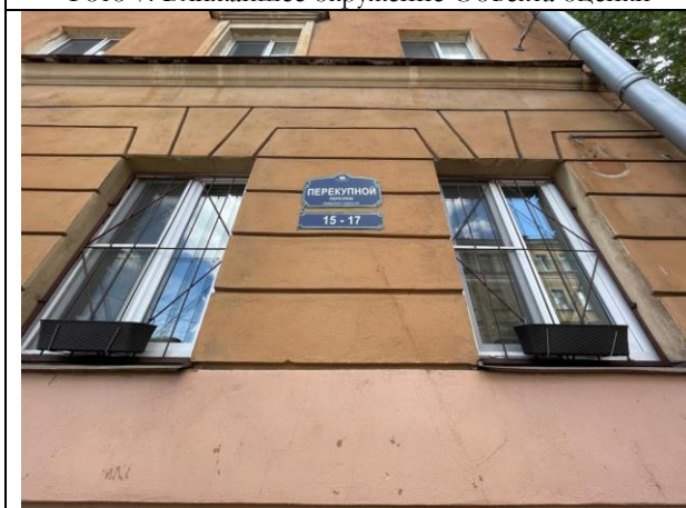
Фото 9. Адрес Объекта оценки
