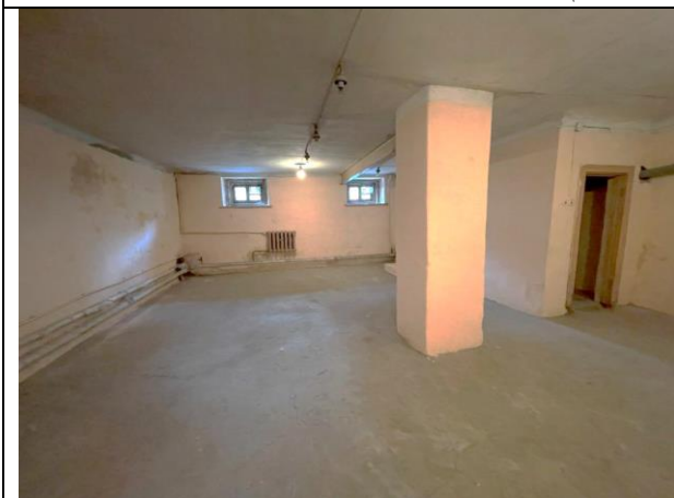
Фото 18. Типичное состояние Объекта оценки (помещение 2-Н)
